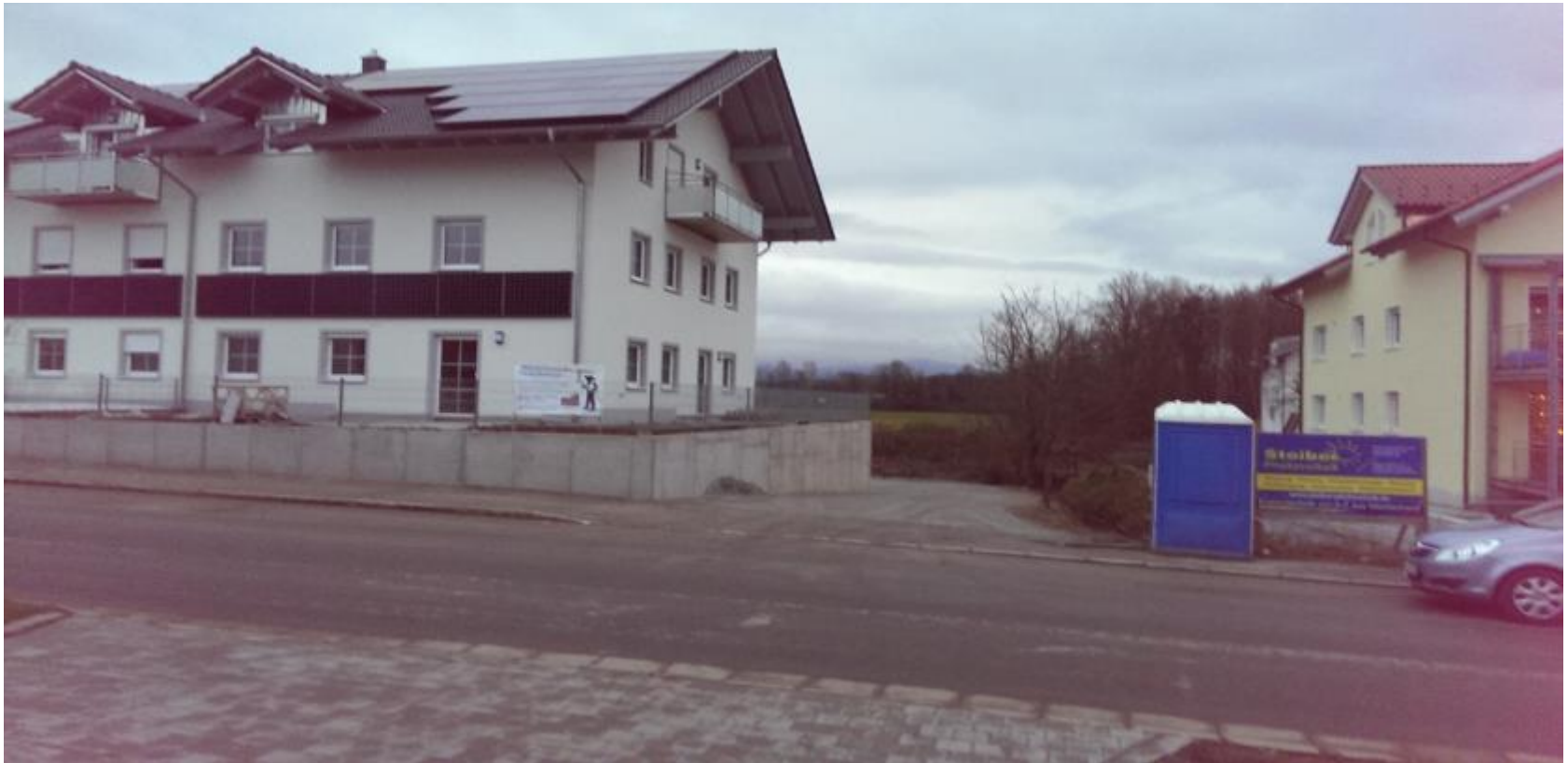
Mehrfamilienhaus PRO Hybrid mit DC und AC PV 9 kW / 20 kWh
