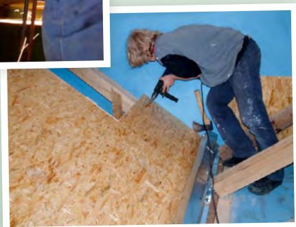
Montage des Lagerraums
