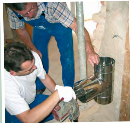
Nachrüsten des Kamins durch den Biowärme-Rauchfangkehrer mittels Einzug eines Edelstahlrohres
