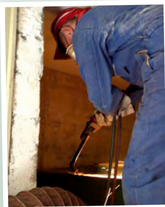
Zerschneiden des alten Öltanks
