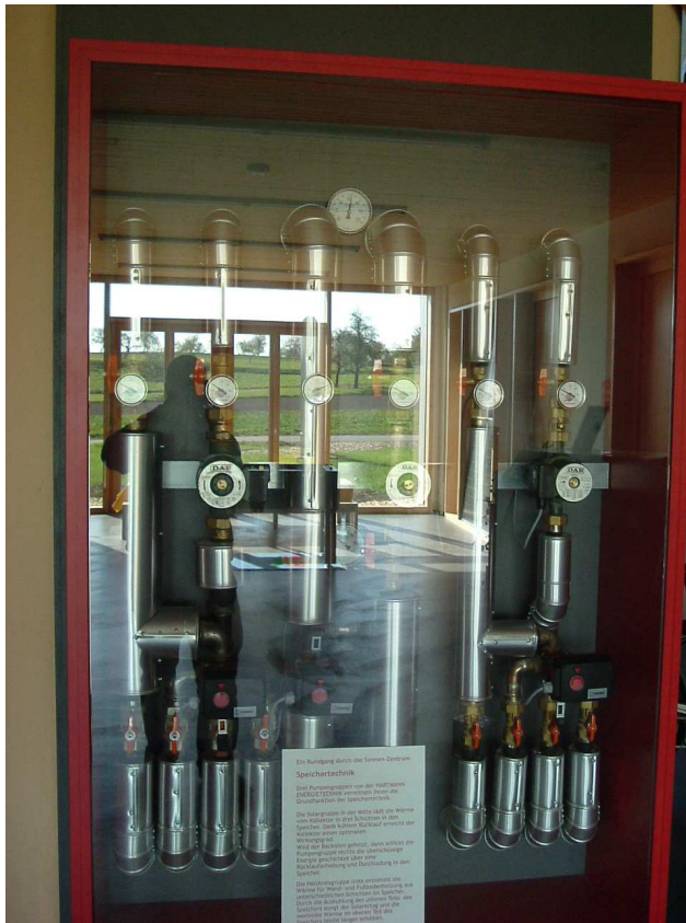
Abbildung 28: Hydraulik des Speichers; Schauwand Sonnen-Zentrum /30/
