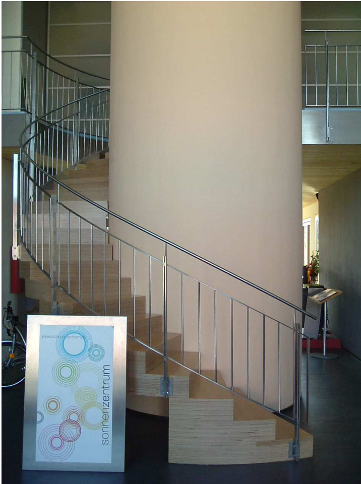
Abbildung 19: Pufferspeicher; Foyer Sonnen-Zentrum /22/
